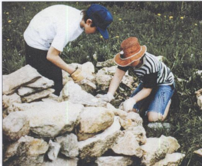
Schüler beim Bau einer Trockenmauer.
