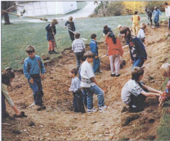
Ein Teich wird ausgehoben.
