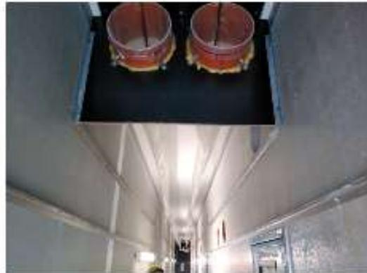
Die Zuluft wird oberhalb der Staldächer aus ca. 12 m Höhe angesaugt. Wechseljalousien öffnen zur windabgewandten Seite. Überwiegend jahreskalte Luft wird an den Dachflächen erwärmt. Bei erstmals in 2021 aufgetretenen Tagestemperaturen von 35 °C ist das System überfrachtet. „Pipe in Pipe“ dient der Temperaturpufferung.
