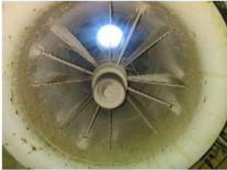
In den Abluftkaminen (der wärmeren) Abferkelabteile sind Luft-Luft-Wärmetauscher integriert, um so bei Bedarf eine Vorluft-Temperierung der Zuluft zu unterstützen.
