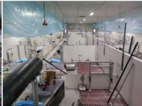
Konventionelle Abferkelabteile, Flüssigfütterung, Einzelabteilabsaugung mit Wärmerückgewinnung, Zuluftschläuche über dem Kopfbereich der Sauen
